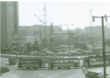
In der Innenstadt wird gebaut.
